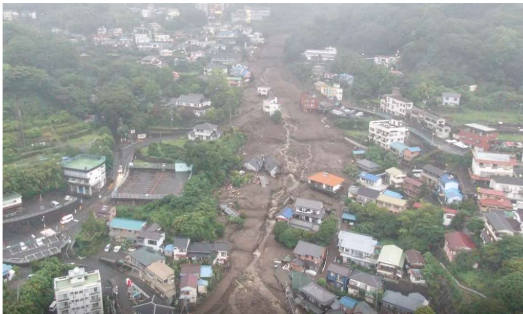
豪雨と盛り土に起因する熱海土砂災害 (2021年7月4日)【静岡県熱海市】 出典：国土交通省
