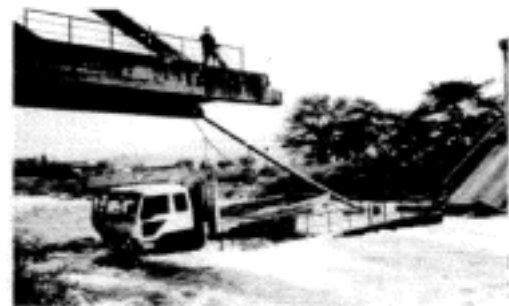
坂本町 町道下田瀬1号線 森田橋の架橋状況（1990年） 国土交通省ホームページより
