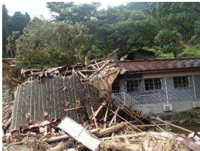
2017年7月 九州北部豪雨で被災し倒壊した家屋（福岡県東峰村（国土交通省HPより））
